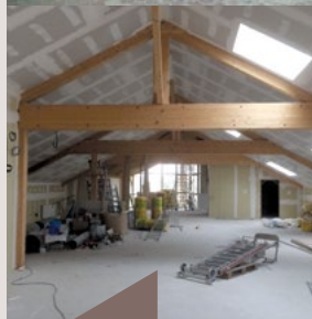
La salle de réception et l'espace collaboratif de travail en chantier.
