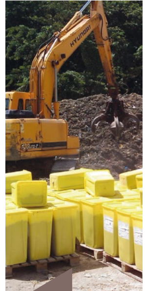
Le chantier DASRI en Guadeloupe.
