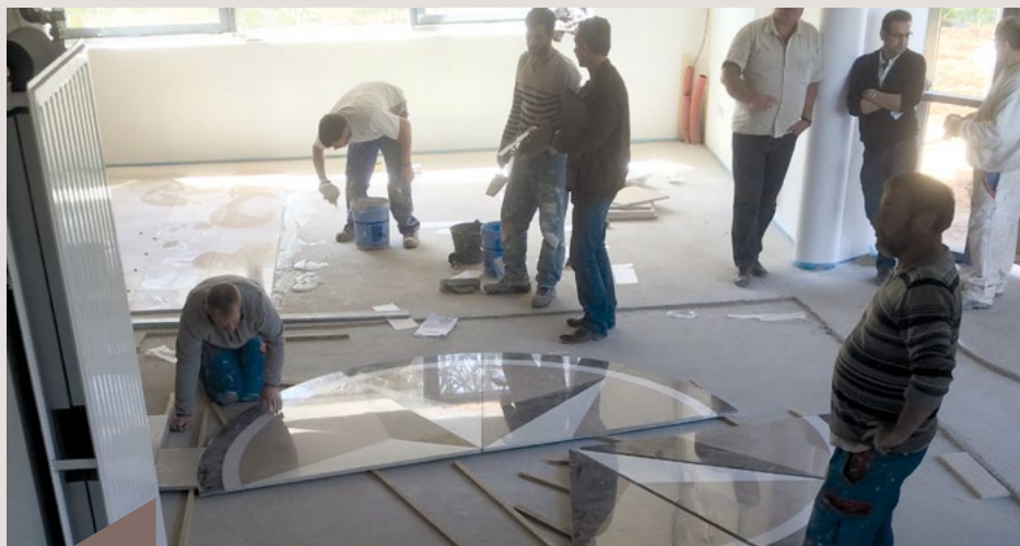
La pose minutieuse de l'étoile lasallienne dans le hall d'entrée de LaFerme.
