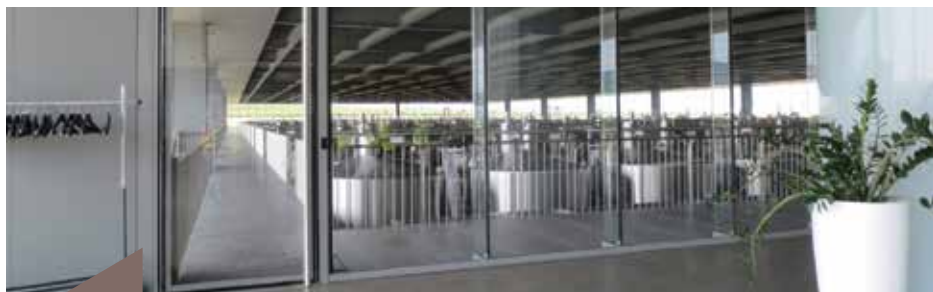
Cuverie Moët et Chandon à Mont-Aigu.
