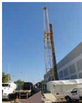
Plateforme de forage profond dans le bassin de Mexico City.
