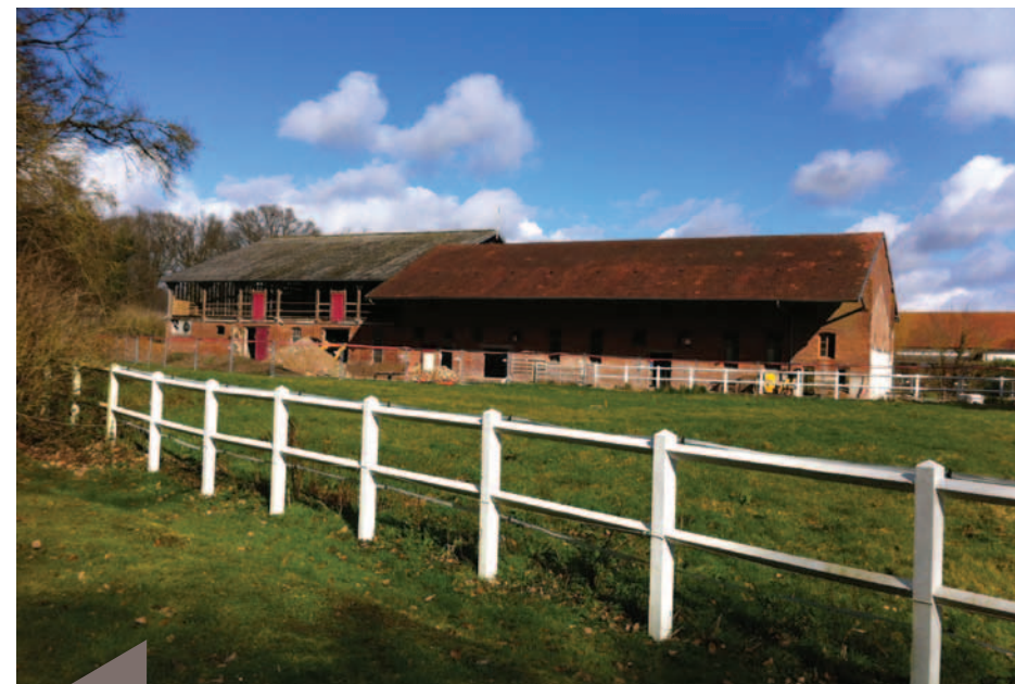
Rénovation de la ferme (vue de l'entrée véhicules).
